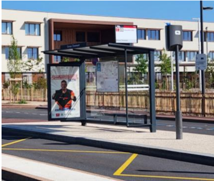
Arrêt de Bus au pied de l'établissement
